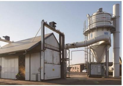
“在尽可能小的面积上建立大型的除尘系统。”以此为目标，我们开发出超强集成RFA系列除尘器，单台除尘风量高达90,000m<sup>3</sup>/h，占地面积仅为13m<sup>2</sup>。一体化设计，将预分离旋风分离器、袋式除尘器和风机集成在一个壳体中，具备高效率的特点，适用于分离几乎所有类型的干粉尘。
